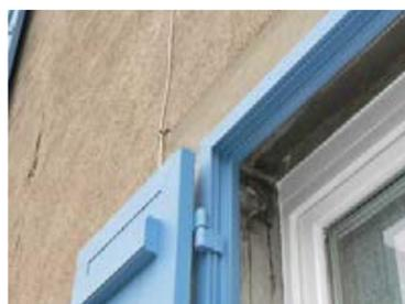
Profil de finition avec joint
